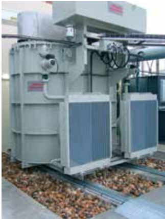
Стационарный маслоохладитель для трансформаторной установки фирмы Bernard & Bonnefond
