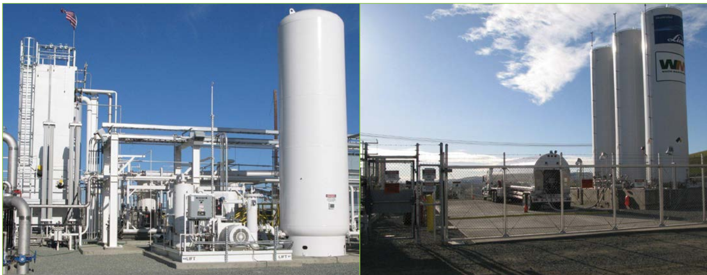
Подача газа с полигона для захоронения отходов на завод СПГ в Алтамонте, Калифорния, с применением смешанного хладагента в качестве технологии для малых станций сжижения.
