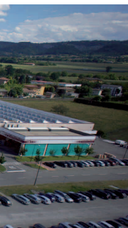
Производственный и логистический комплекс New production and logistic pole
