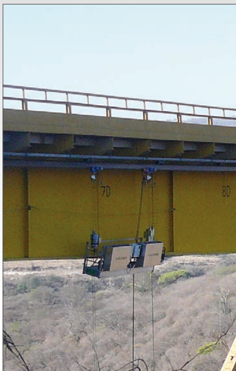
Plataforma suspendida para trabajos bajo tablero de puente
