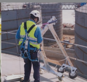
TRABAJOS EN ALTURA
