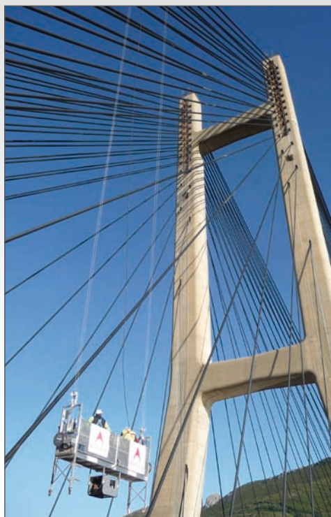
Plataforma colgante para puente atirantado
