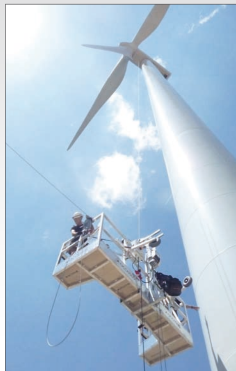
Plataforma colgante para aerogeneradores
